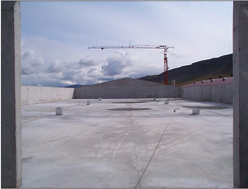
MYND 2.6 Horft inn í eldishús 2 að Hurðarbaki meðan það var í byggingu.
