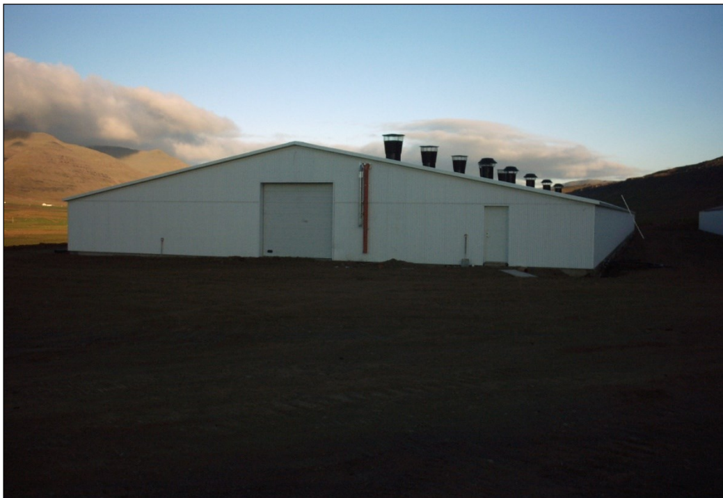
MYND 2.7 Fullbyggt eldishús nr. 2 að Hurðarbaki.
